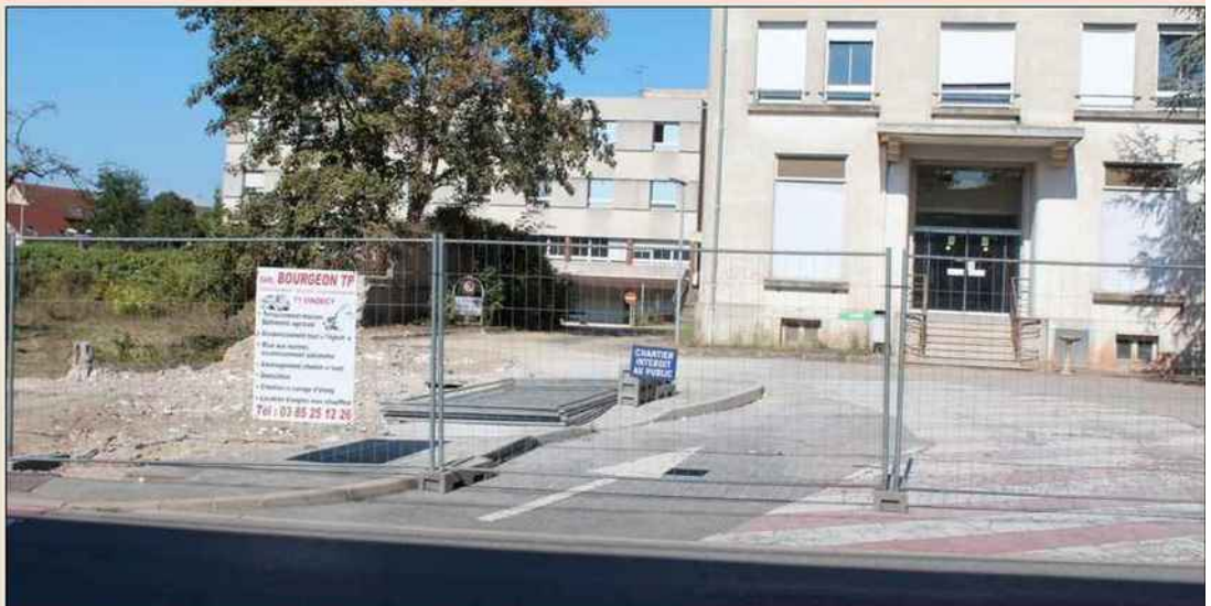
■ Un premier chantier confié à une entreprise locale. Photo Richard PLAA
