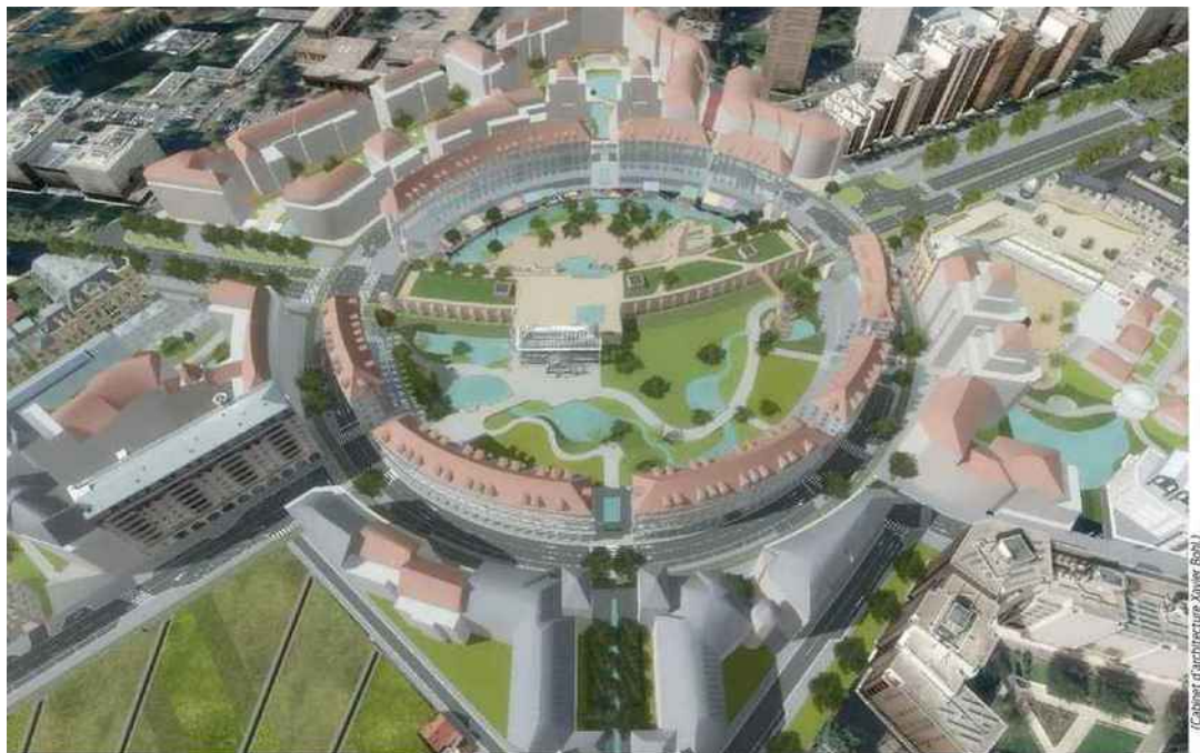
Pour un budget de 153 M€ HT, la mairie (LR) construit un quartier de 11,5 ha et 2 200 logements au-dessus de la N 13. Le premier immeuble sera livré en juin et déjà les appartements se vendent comme des petits pains.
